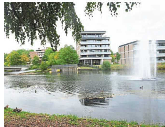
Mehr als zwei Jahre stand das Erdgeschoss des Bergertor-Hochhauses leer, jetzt ist dort der Fitness-Club zu Hause. Foto: Moritz Winde
